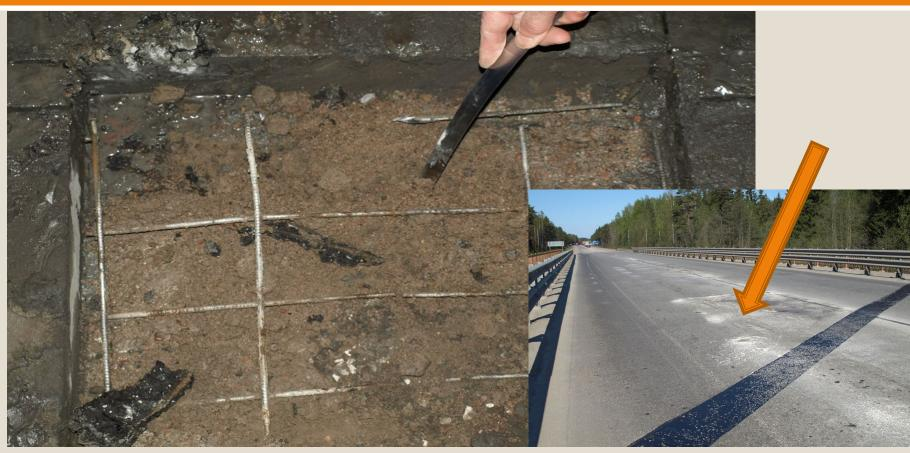
Полная потеря несущей способности бетонного защитного слоя гидроизоляции, разрушение самой гидроизоляции
