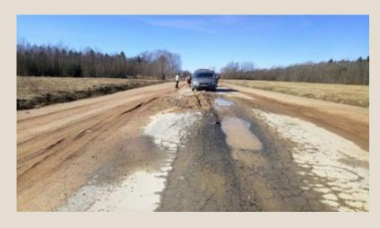
Эрозия верхних слоев а/б покрытия, выкрашивание, образование выбоин
